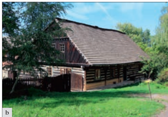
Mužský (okres Mladá Boleslav), usedlost čp. 17, obytné stavení: a – stav v dubnu 2008 (foto J. Tichá). Povrch zápraží kryla betonová krusta. Obnova probíhala během jara a léta a dotkla se podezdívek, roubení a podlahy světnice a přilehlého úseku zápraží; b – dokumentuje stav po obnově v září 2015 (foto A. Rákosníková).
