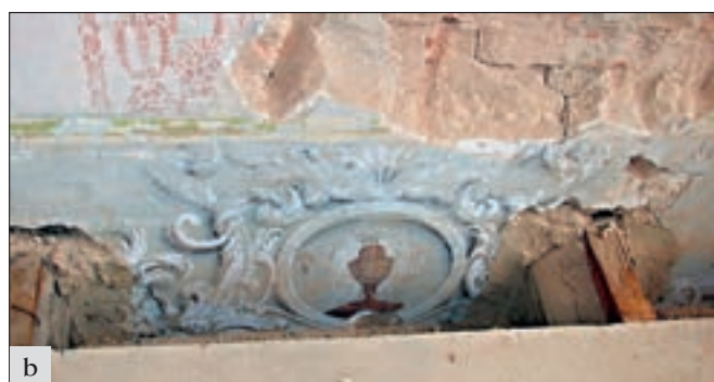
Dolní Břežany (okres Praha-západ), zámek, nově odkrytý strop a malba. V tomto roce byly zahájeny stavební práce na obnově zámku, a to sanačními pracemi, jež zahrnovaly odstranění nehodnotných a degradovaných konstrukcí a zařízení prvků zejména z 2. poloviny 20. století. Při této příležitosti byly odhaleny velmi hodnotné konstrukce a prvky ze starších vývojových fází objektu. V severovýchodní nárožní místnosti 2. NP byly odhaleny dvě renesanční upadlé niky s šedou paspartou, přičemž ve vnitřní výplni právě z nich byly nalezeny dva fragmenty profilovaných žebrových článků – přípory, ostění (?) z předcházející gotické fáze dolnobřežanské vodní tvrze: a – v sousední místnosti v severním křídle byl mezi 2. NP a 3. NP zcela odhalen předpokládaný malovaný záklopový strop ze začátku 17. století. V jihovýchodním nároží byla objevena dvoupodlažní zámecká kaple, jenž byla asi v 1. polovině 19. století opatřena dekorativní výmalbou v rámci iluzivní architektury; b – na obrázku je detail medailonu v rozvilině s kalichem a hostií v provedení chiaroscuro (foto E. Zápalková).
