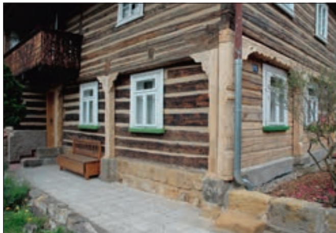
Nové Osinalice (okres Mělník), čp. 16. Roubený patrový dům není zapsanou památkou, přesto však významně ovlivňuje charakter památkové rezervace. Díky citlivému přístupu vlastníků byl odstraněn novodobý obklad z eternitových šablon a obnovena původní podoba vnějšího pláště, jehož nejzdobnějším prvkem je bohatě profilovaná podstávka, obnovená podle místních analogií (foto J. Berková).
