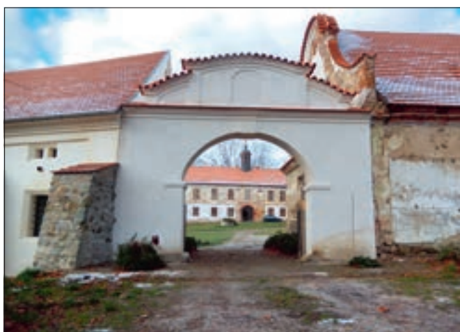
Třebešice (okres Benešov), areál zámku, obnova vstupní brány. Barokní brána vjezdu do hospodářského dvora zámku byla navržena a znovu postavena podle historické fotografie a pozůstatků a otisků zjištěných průzkumem (foto D. Primusová).
