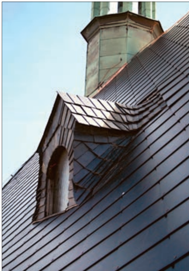
Příbram (okres Příbram), kostel sv. Jakuba Staršího na Masary-kově náměstí – Centrální památka ochranného pásma Příbram, sedlový vikýř presbytáře z regotizující rekonstrukce konce 19. století. Při obnově byla zachována, respektive obnovena, historická břidlicová krytina vikýřů bez použití oplechování, na lodi a presbytáři byla břidlice nabazena střešní krytinou z ce-mentovláknitých šablon Cembrit Horal (foto D. Havliková).
