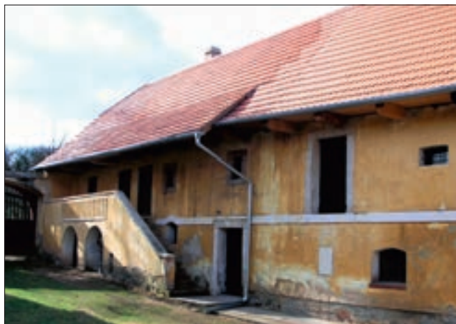
Třebíz (okres Kladno), usedlost čp. 2, přední část stavby – dokončená poslední etapa obnovy stropů, krovu a střešního pláště stáží (foto M. Hanzlíková).
