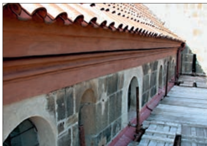
Tismice (okres Kolín), bazilika Nanebevzetí P. Marie. Pohled na převýšenou hlavní loď ze severu po plošném zpevnění kvádřového zdiva s hrubým spárováním před začištěním, po začištění barokně upravených půlkruhových oken a po úpravě hlavní římsy s navrácenou terakotovou barevností (foto E. Zápalková).
