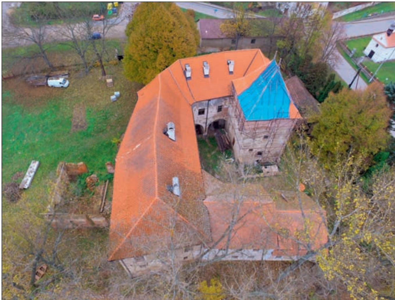
Popovice (okres Benešov), tvrz, dostavba věže. Celková obnova tvrze pokračovala zastřešením věže. Na obvodové zdivo věže, které bylo navýšeno, byl postaven nový krov, který byl v předešlých letech sestaven na zemi, a bylo započato s pokládkou prejzové krytiny (foto V. David).
