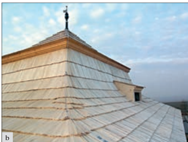
Hradenín (okres Kolín), tvrz čp. 13. Dokončování šindelové střechy na replice historického krovu tvrze dle výkresů zachycujících renesanční krov, v baroku dodatečně upravený na mansardovou střechu; byly prováděny tesařské spoje a ruční opravy povrchů trámů: a – celkový pohled na tvrz po rekonstrukci historického krovu dle archivních fotografií a zaměření; b – detail šindelové krytiny (foto D. Havlíková).
