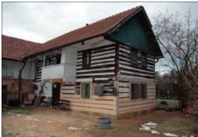
Lobeč (okres Mělník), čp. 7. Obnova roubených stěn světnice si vyžádala v důsledku velmi špatného stavu trámů téměř celkovou výměnu. Součástí prací bylo rovněž přezdění podezdívky z pískovcových kvádrů. Po vyschnutí nového dřeva bude v příštím roce následovat vymazání spár a obnova vnitřních bliněných omítek (foto J. Berková).
