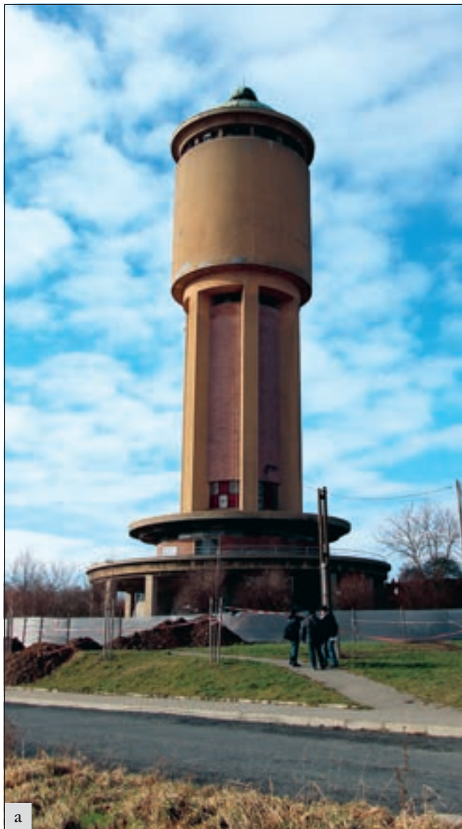
Kolín (okres Kolín), věžový vodojem na Pražském předměstí: a – stav v lednu 2015. Významná vodohospodářská památka byla upravena na vyhlídkovou věž. Opravu pláště, opatřeného různobarevnými kamenicky opracovanými dřevými omítkami se však nepodařilo provést tak, aby byl podtržen působivý efekt této úpravy, typické pro 1. třetinu 20. století; b – stav v listopadu 2015 (foto A. Rákosníková).
