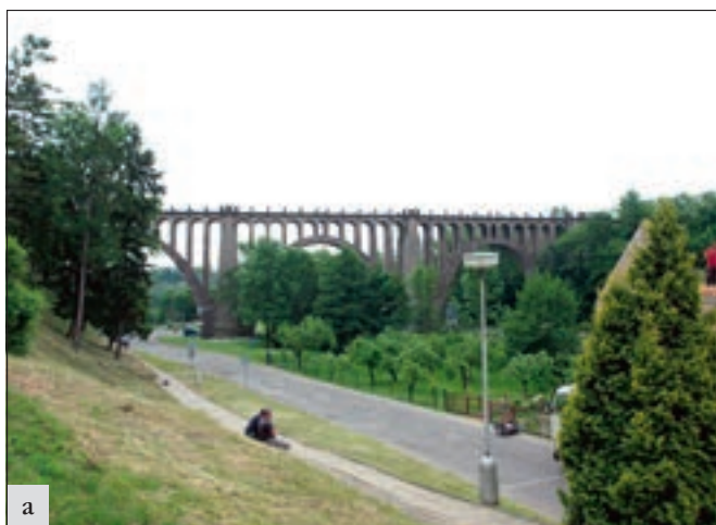
Dolní Krnsko (okres Mladá Boleslav), železniční most přes údolí Strenického potoka: a – stav v červnu 2015. Most s železobetonovými klenbami vetknutými do starších kamenných opěr a pilířů vytváří s okolním hlubokým údolím mimořádně působivý celek; b – stav v únoru 2016. V rámci jarních dokončovacích prací bude muset být řešen především problém změny barevnosti reprofilační bmoty pro železobetonovou část konstrukce v úseku, kde byla aplikována již v pokročilém ročním období (foto A. Rákosníková).
