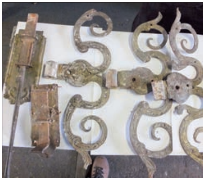
Benátky nad Jizerou (správní obvod Mladá Boleslav), kostel Narození Panny Marie, kování dvoukřídlých dveří vedoucích ze sakristie do kostela, stav během restaurování. V rámci restaurování došlo k sejmutí kování na barokních dubových dveřích, dále byl proveden průzkum povrchových úprav. Na jeho základě bylo následně obnoveno cínování povrchu a kování bylo osazeno zpět na restaurovaná dvevní křídla (foto L. Maděrová).
