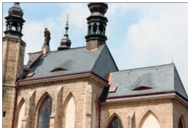
Kutná Hora-Sedlec, kaple Všech Svatých s kostnicí. Náročná akce generální obnovy kaple Všech Svatých s kostnicí v Sedlci pokračovala další etapou, v rámci níž byla dokončena obnova střech horní kaple a jižní terasa spodní kostnice. Při obnově střech se na podnět odborných pracovníků NPÚ podařilo prosadit neobvyklé řešení spodního ukončení střechy pod žlabem, kde namísto podkladního plechu je pás šablon. Toto řešení spolu s odlišnou skladbou krytiny střechy lodi a presbytáře navazuje na stav po obnově v 70. letech 19. století a zachycují její historické fotografie (foto A. Pospíšil).
