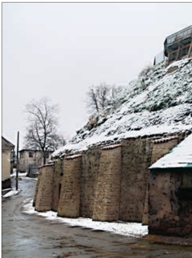
Brandýs nad Labem (okres Praha-východ), zámek – bastion. K nejnáročnějším sanačním pracím v areálu brandýského zámku náleželo statické zajištění a celková obnova východního raně barokního zámeckého bastionu, který byl destruován po vydatných deštích. Byla realizována vnitřní zpevňující konstrukce, byl upraven povrch celého bastionu včetně horní pochozí dlažby, po obvodu bastionu byly přistavěny nové zděné opěrné pilíře, do nichž byly vloženy části nosných konstrukcí stavby (foto P. Kroupa)
