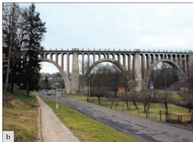
Dolní Krnsko (okres Mladá Boleslav), železniční most přes údolí Strenického potoka: a – stav v červnu 2015. Most s železobetonovými klenbami vetknutými do starších kamenných opěr a pilířů vytváří s okolním hlubokým údolím mimořádně působivý celek; b – stav v únoru 2016. V rámci jarních dokončovacích prací bude muset být řešen především problém změny barevnosti reprofilační bmoty pro železobetonovou část konstrukce v úseku, kde byla aplikována již v pokročilém ročním období (foto A. Rákosníková).
