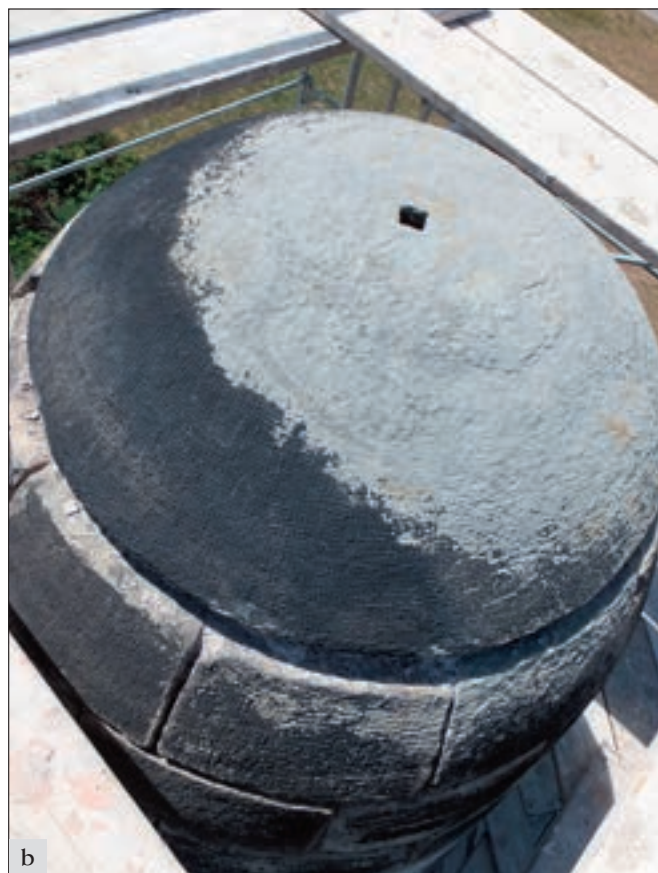
Lipany (správní obvod Český Brod), pomník bitvy u Lipan: a – celkové restaurování pláště mohyly vztyčené v roce 1881 řešilo zejména obnovu spárování a ošetření jednotlivých bloků, některé byly znovu osazeny. Konzervovány byly také původní kovové nápisové desky; b – detail vrchlíku s patrným opracováním povrchu kamene pemrlováním (foto L. Maděrová).
