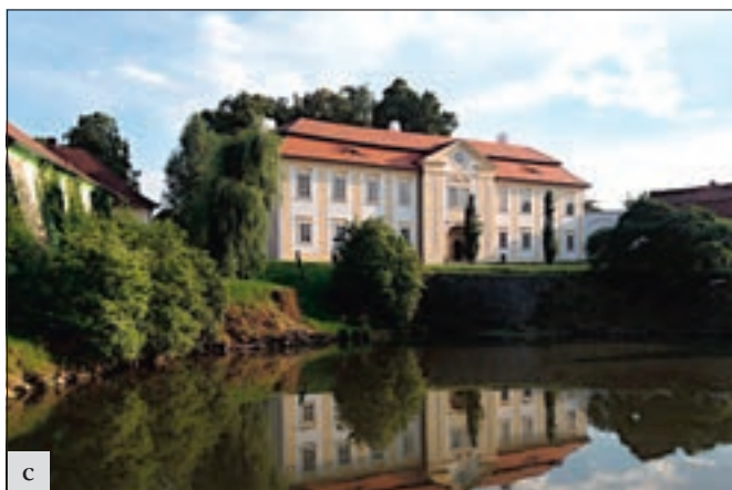
Skrýšov (okres Příbram), obnova zámku. Zámek ve Skrýšově prošel několikaletou obnovou, která vyvrcholila obnovou fasád: a – řada architektonických článků byla ve špatném stavu. Opravě předcházelo provedení operativního průzkumu a dokumentace; b – architektonické články, jak ukazuje např. detail šambrány se suprafenestrou, se podařilo kvalitně štukátěrsky opravit; c – úspěšný výsledek dokládá nejen předešlý detail, ale i celkový pohled na zámek z prostoru dvora (foto H. Řepková a K. Roden).
