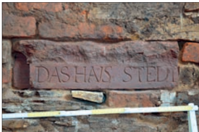
Poděbrady (okres Nymburk) – barokní dům čp. 41. Při obnově domu, který dlouho sloužil jako radnice, byl nalezen drubotně zazděný pískovcový kus římsy, podle nápisu asi z 2. pol. 16. až počátku 17. století (foto V. Jesenský).
