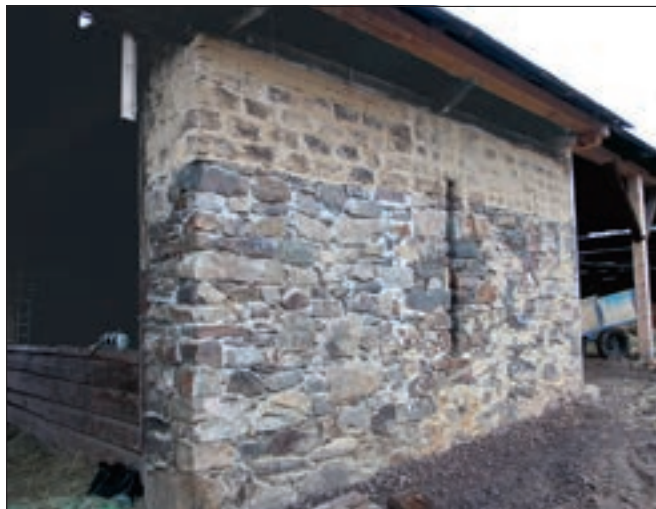
Olešná (okres Beroun), stodola s navazující kolnou v areálu usedlosti čp. 12, jižní zeď východní perny. V levé části obvodové zdi bylo v předchozích etapách obnovy přezděno utržené nároží. V nadezdívce z nepálených cihel je patrná dozdvíka z cihel pálených. Obnova nadezdívky v pravé části se v letošním roce podařila bez doplnění úseků páleného zdiva i přes napojení skrytého železobetonového věnce (foto M. Hanzlíková).
