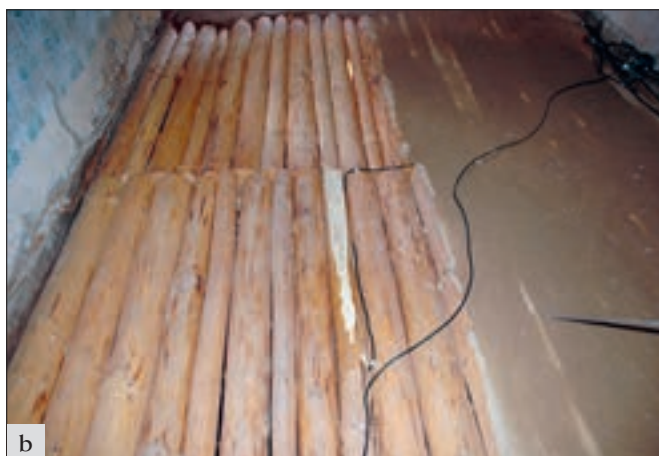
Vidím (okres Mělník), čp. 67: a – vnější plášť roubeného stavení po dokončení vymazávek spár; b – v rámci obnovy interiéru bylo这件 obnovit původní bliněné omítky a vyměnit také zcela dožilý strop nad výměnkářskou světničkou při zachování jeho původní tradiční skladby z loupáných povalů omazaných bliněnou kaší (foto J. Berková). Tento druh historické konstrukce, která plní současně funkci podlahy v 1. patře, má lepší nosnost než klasický prkenný záklop, v kombinaci s hlinou má rovněž velmi dobré tepelné izolační vlastnosti (foto J. Berková).
