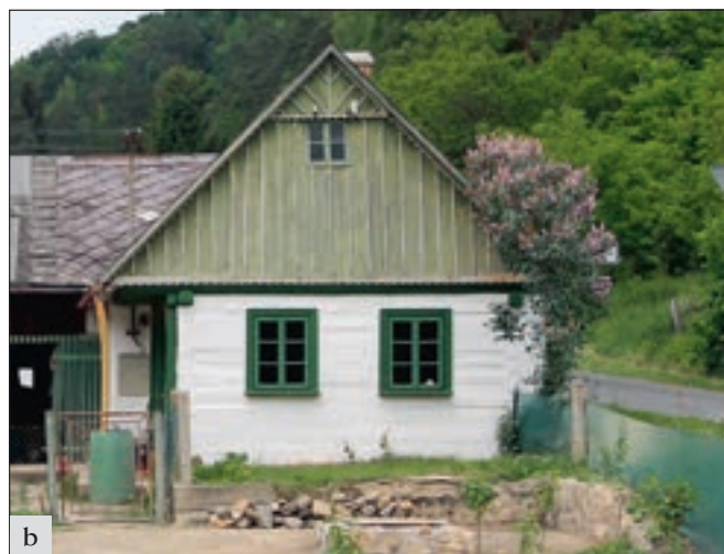
Podboře (okres Mladá Boleslav), usedlost čp. 5: a – stav v lednu 2012 (foto J. Tichá). Obnova roubení světnice proběhla již v roce 2014, dokončení vymazávek a obílení na jaře 2015; b – stav v květnu 2015 (foto A. Rákosníková).
