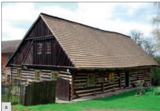
Mužský (okres Mladá Boleslav), usedlost čp. 17, obytné stavení: a – stav v dubnu 2008 (foto J. Tichá). Povrch zápraží kryla betonová krusta. Obnova probíhala během jara a léta a dotkla se podezdívek, roubení a podlahy světnice a přilehlého úseku zápraží; b – dokumentuje stav po obnově v září 2015 (foto A. Rákosníková).
